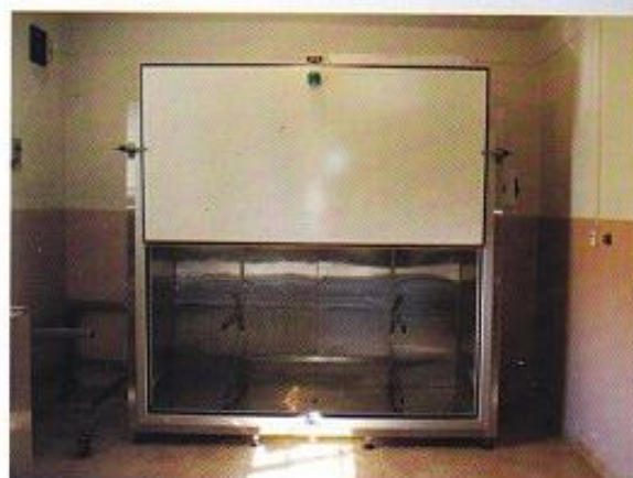
KOMORA CHŁODNICZA BOCZNEGO ZAŁADUNKU PRZEZNACZONA DO PRZECHOWYWANIA 3 CIAŁ W TRUMNACH
