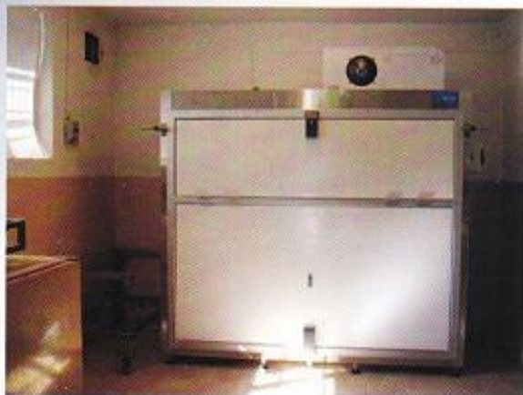
KOMORA CHŁODNICZA BOCZNEGO ZAŁADUNKU PRZEZNACZONA DO PRZECHOWYWANIA 3 CIAŁ W TRUMNACH
